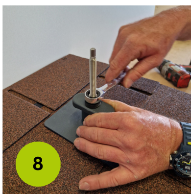
*Verschrauben mit der Stockschraube
