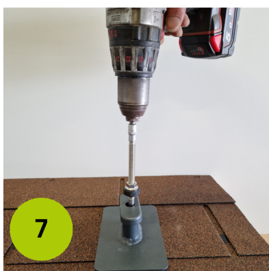
*Verschrauben mit der Stockschraube
