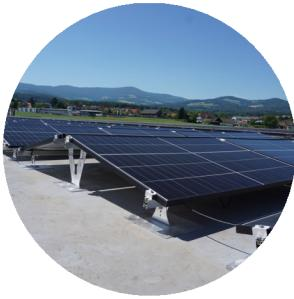
Hauptsächlich wird dieses System für das reine Flachdach bis 3° Dachneigung in einer Ost-West Belegung verwendet, kann aber auch für eine reine Südausrichtung zum Einsatz kommen. In diesem Fall ist es möglich am höheren Halter an der Nordseite mühelos ein Windleitblech zu montieren. Durch eine werkseitige Ausstanzung am hohen Halter hat man die Möglichkeit einen zum System passenden Kabelkanal einzuklippen.
