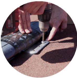
Je nach Dachaufbau und Dachhaut kann zwischen mechanischer und verschweißter Befestigung unter Berücksichtigung der örtlichen Gegebenheiten gewählt werden.
