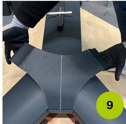
Das vor-markierte Gratverteilerblech an einer der markierten Linien passend an alle 3 Seiten vorschneiden und an den Enden einschlagen.
