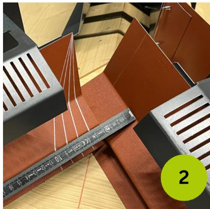
Zweites UK - Blech am Grad durch Auswahl einer der vor-markierten Linien anschneiden.
