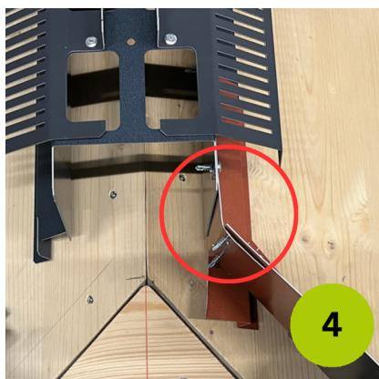
Fertig verschraubt mit den rückdreh sicheren Edelstahlschrauben.
