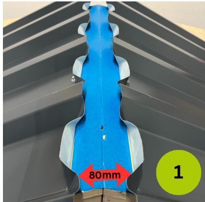
Das Trapezblech ist in der wasserführenden Ebene mittels Falte hochzustellen.
