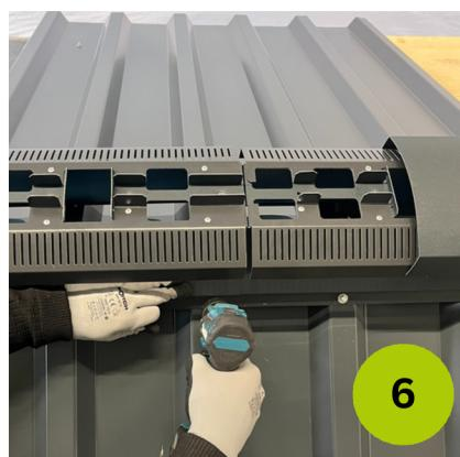
Die Abdeckkappe ist an den vorgestanztem Loch durch Nieten oder Schrauben zu sichern.
